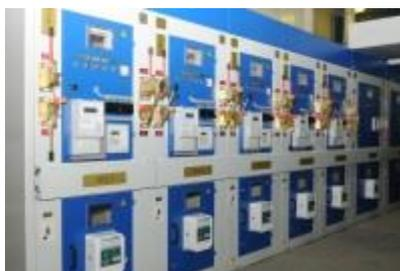
камера сборная одностороннего обслуживания, предназначена для работы в электрических установках трехфазного переменного тока частоты 50 и 60 Гц напряжением 6 и 10 кВ для системы с изолированной или заземленной через дугогасящий реактор нейтралью.
