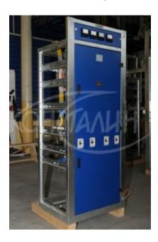
Панели ЩО-70 предназначены для приема и распределения электрической энергии в сетях напряжением до 1000 В частотой 50 Гц с глухозаземленной нейтралью, дистанционного, автоматизированного и ручного управления, контроля, сигнализации и защиты оборудования от токов короткого замыкания и перегрузок, защиты людей от поражения электрическим током.
