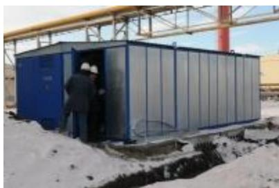
2КТП-40 комплектная двухтрансформаторная подстанция наружной установки трехфазного переменного тока частотой 50 Гц, представляет собой электротехническое устройство, предназначенное для приема, преобразования (по уровню напряжения при помощи силовых трансформаторов), передачи и распределения электрической энергии.
